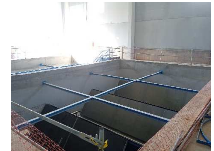
Tolva (3) recepción lodos. (Pendiente inst. tapas AUT)
