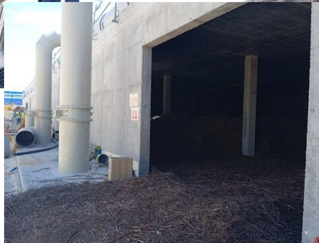
Biofiltros. Conducciones salida
