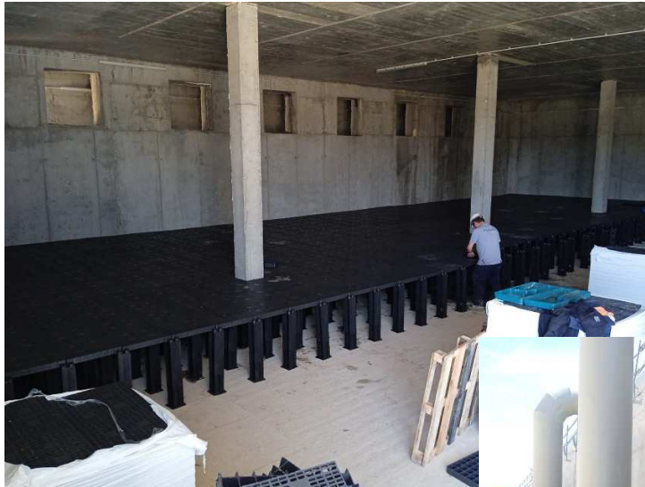
Biofiltros. Fase ejecución falso fondo
