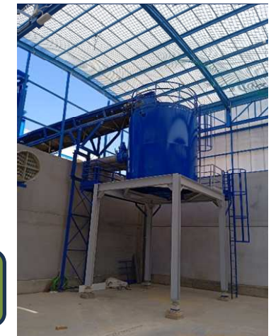
Tolva (3) recepción lodos. (Pendiente inst. tapas AUT)
