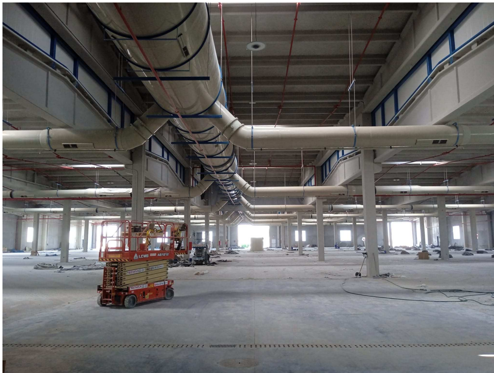
Nave almacenamiento y maduración compost
