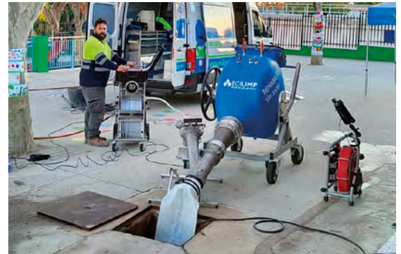
Rehabilitación de tuberías
