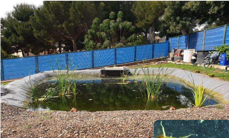
HAFS Línea I (recibe el efluente del humedal con fango)
