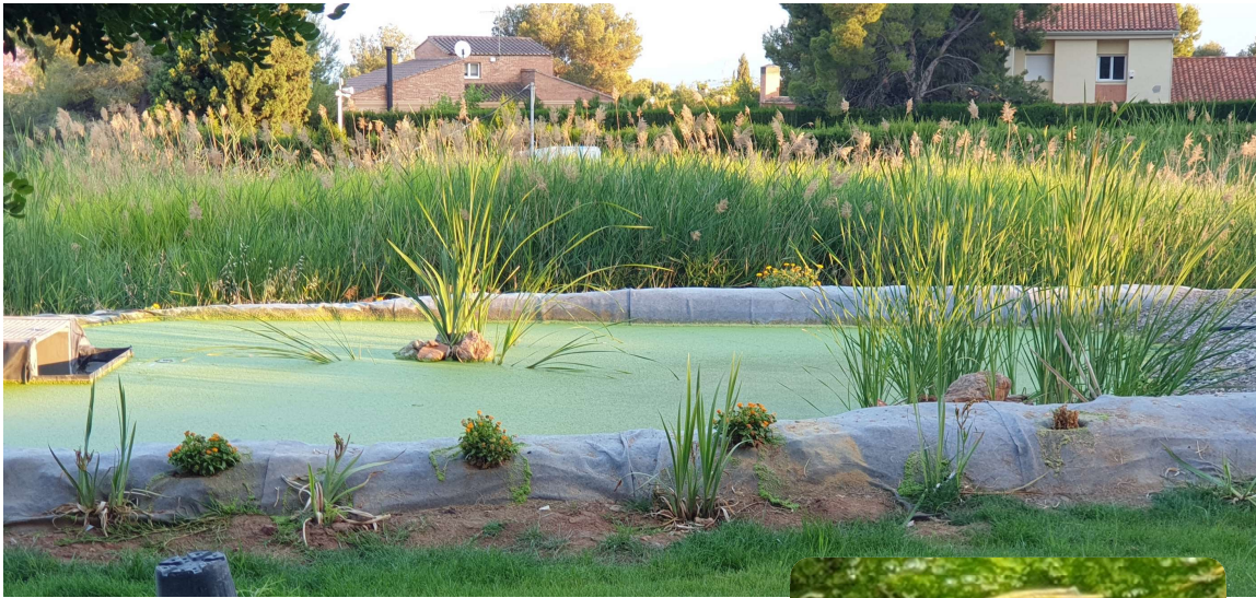
HAFS Línea II (recibe el efluente del tratamiento secundario)
