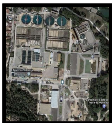
ETAP La Presa.
