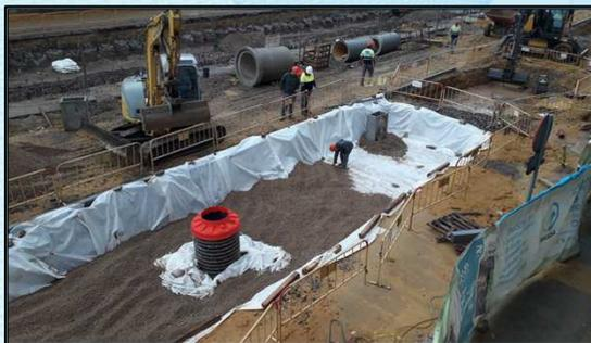
Depósitos de Retención de Aguas Pluviales. DRAP
