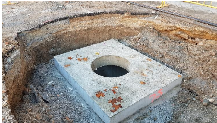
Ejecución de arquetas registrables
