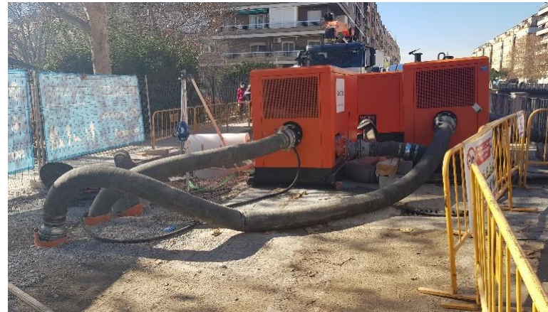
Preparación de bombeo para desvío de caudal circulante
