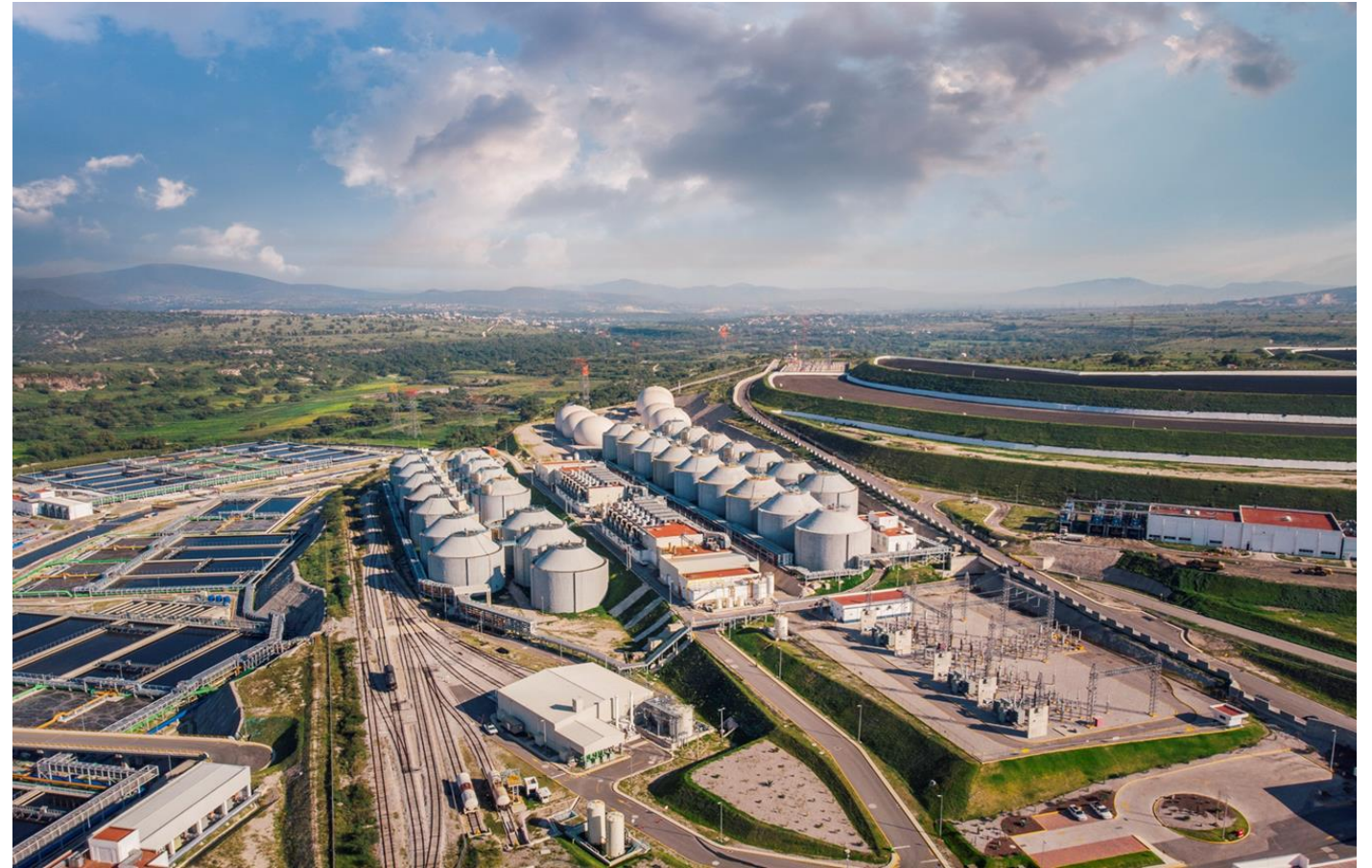
PTAR ATOTONILCO– MEXICO 42 m 3 /sg
