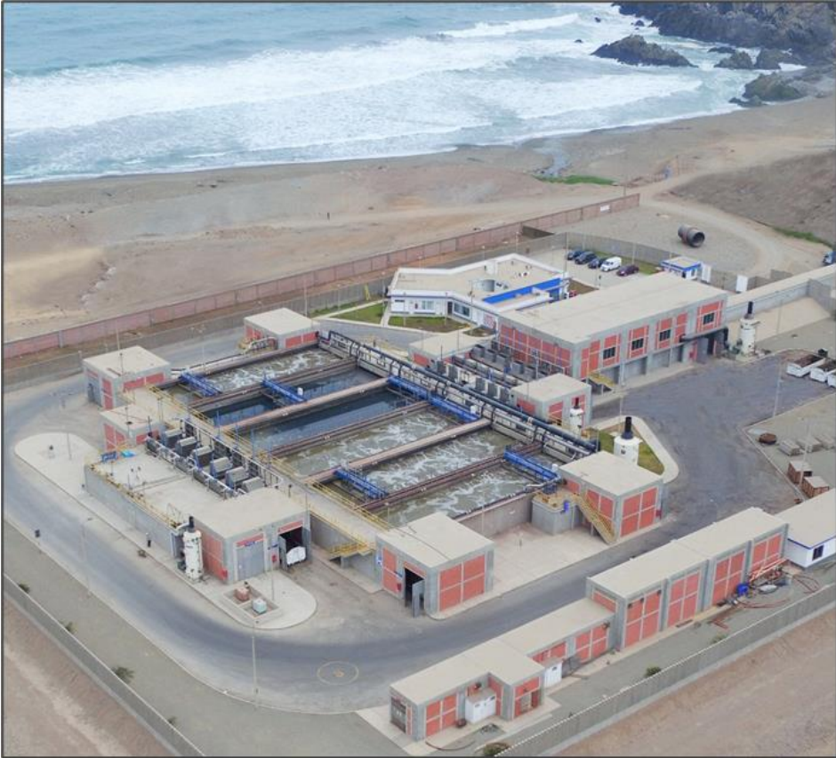
PTAR LA CHIRA – PERU 15 m 3 /sg - Solo Pretratamiento y 1 º
