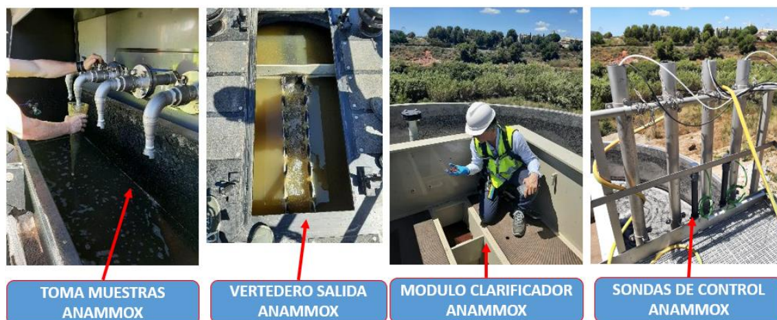
Figura (7). Foto con detalles del reactor ANAMMOX® de Rubí
