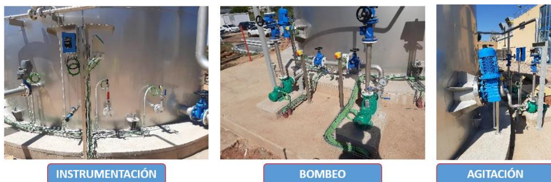
Figura (8). Foto con detalles del tanque de homogenización y bombeo
