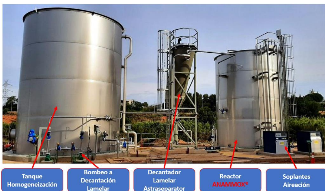
Figura (6). Foto de los elementos principales que componen el proceso ANAMMOX® de Rubí
