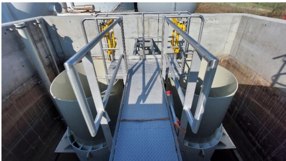
Figura (2). - Detalle de los separadores de fango anammox granular en el reactor ANAMMOX®
