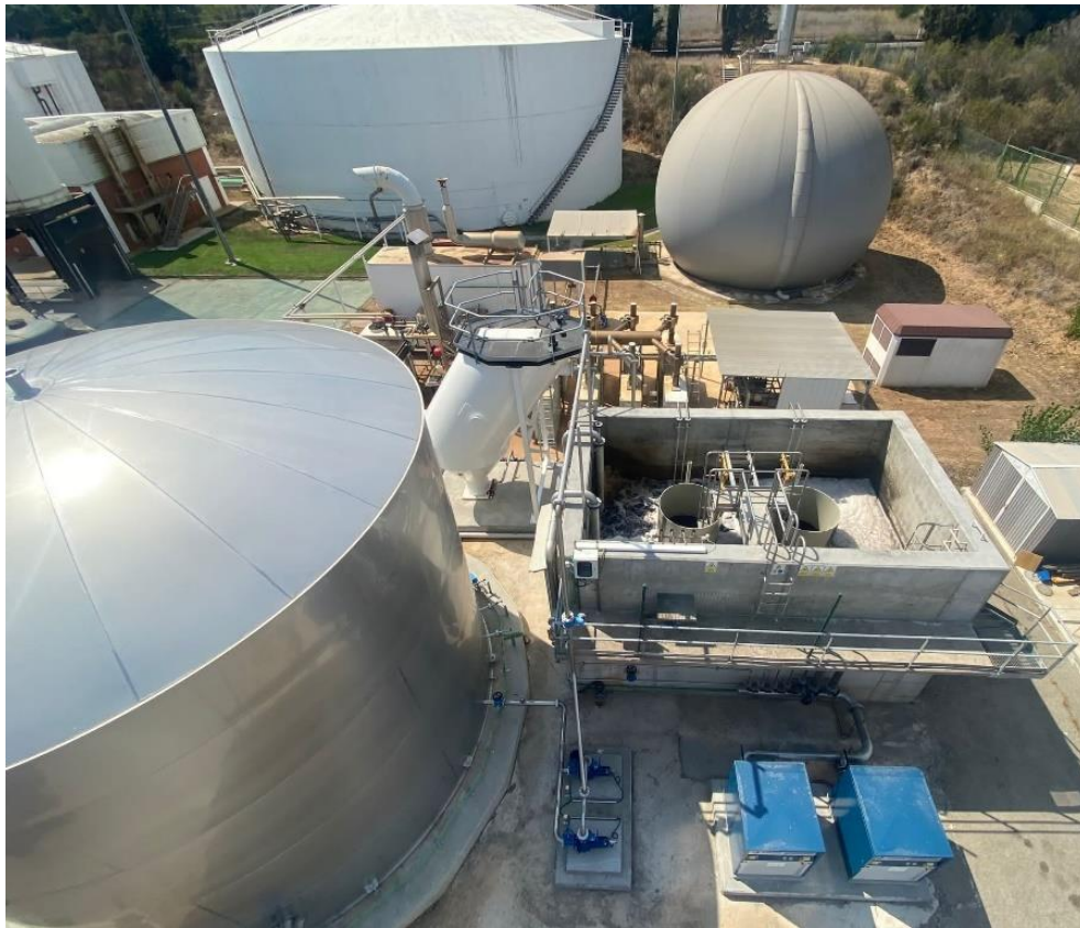
Figura (1). - Vista aérea del tanque de homogeneización y reactor ANAMMOX®
