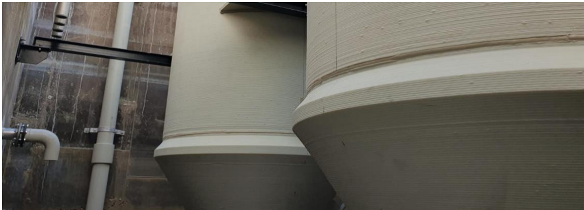
Figura (3). - Detalle de los separadores de fango anammox granular en el reactor ANAMMOX® impresos en 3D
